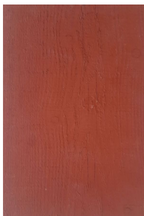
gevelbekleding; rood hout
